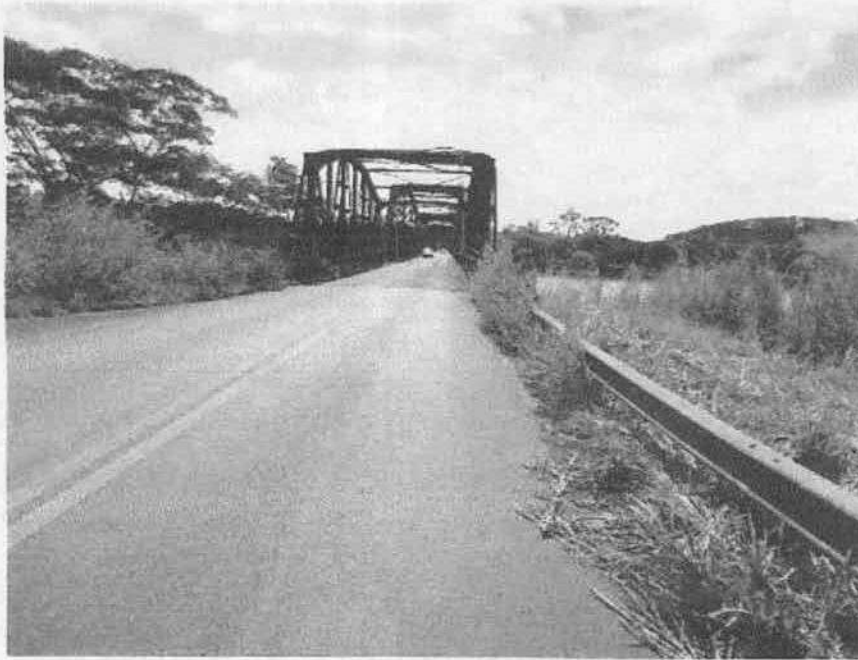
Vista da SP 328 – Acesso as áreas, nesta foto pode ver além da ponte as duas áreas sendo uma do lado direito da estrada e a segunda do lado esquerdo.
