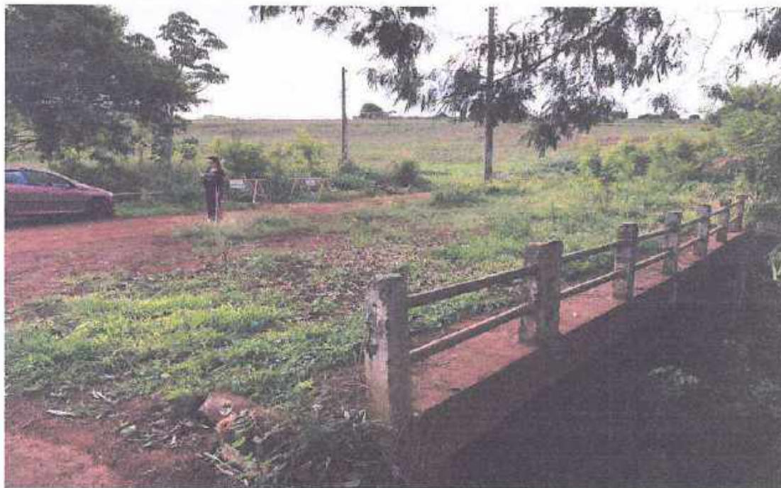
FOTOGRAFIA 1. Ponte sobre o Córrego da Saudade.
