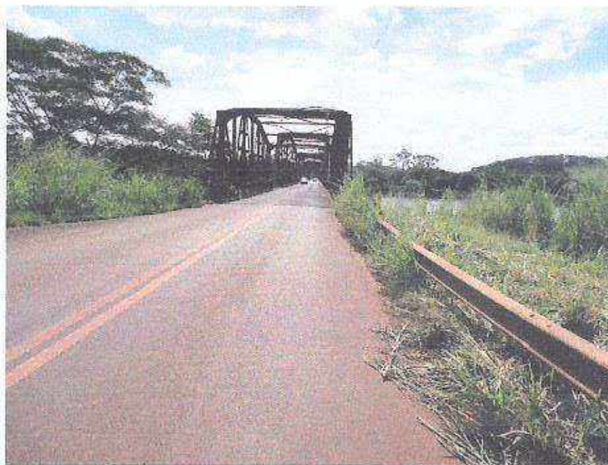
Vista da SP 328 – Acesso as áreas, nesta foto pode ver além da ponte as duas áreas sendo uma do lado direito da estrada e a segunda do lado esquerdo.
