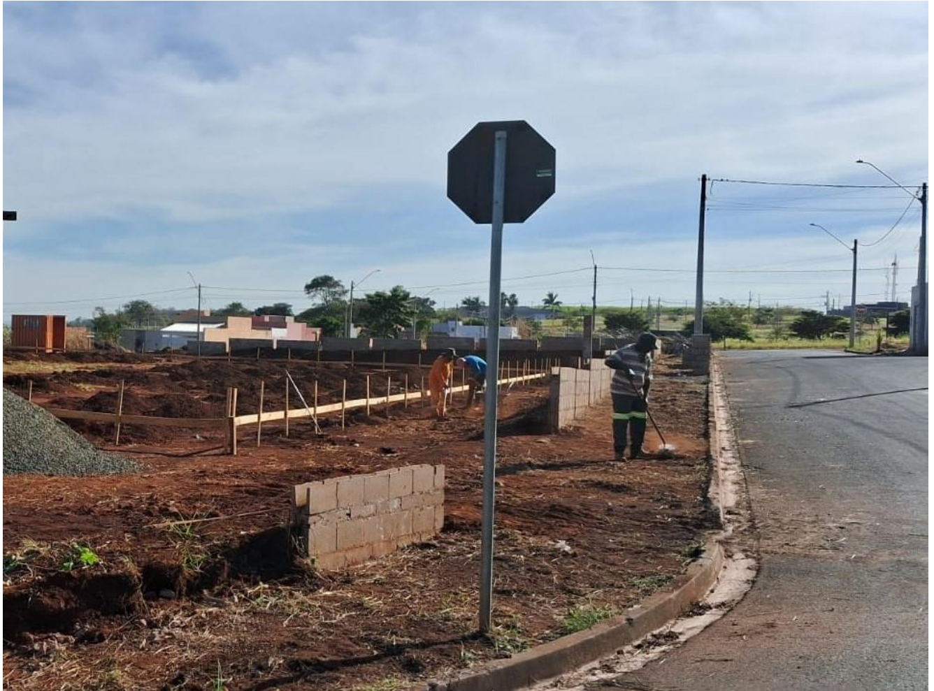
Foto 10 - Referente aos serviços de gabarito da obra para escavação para realização das vigas baldrames.
