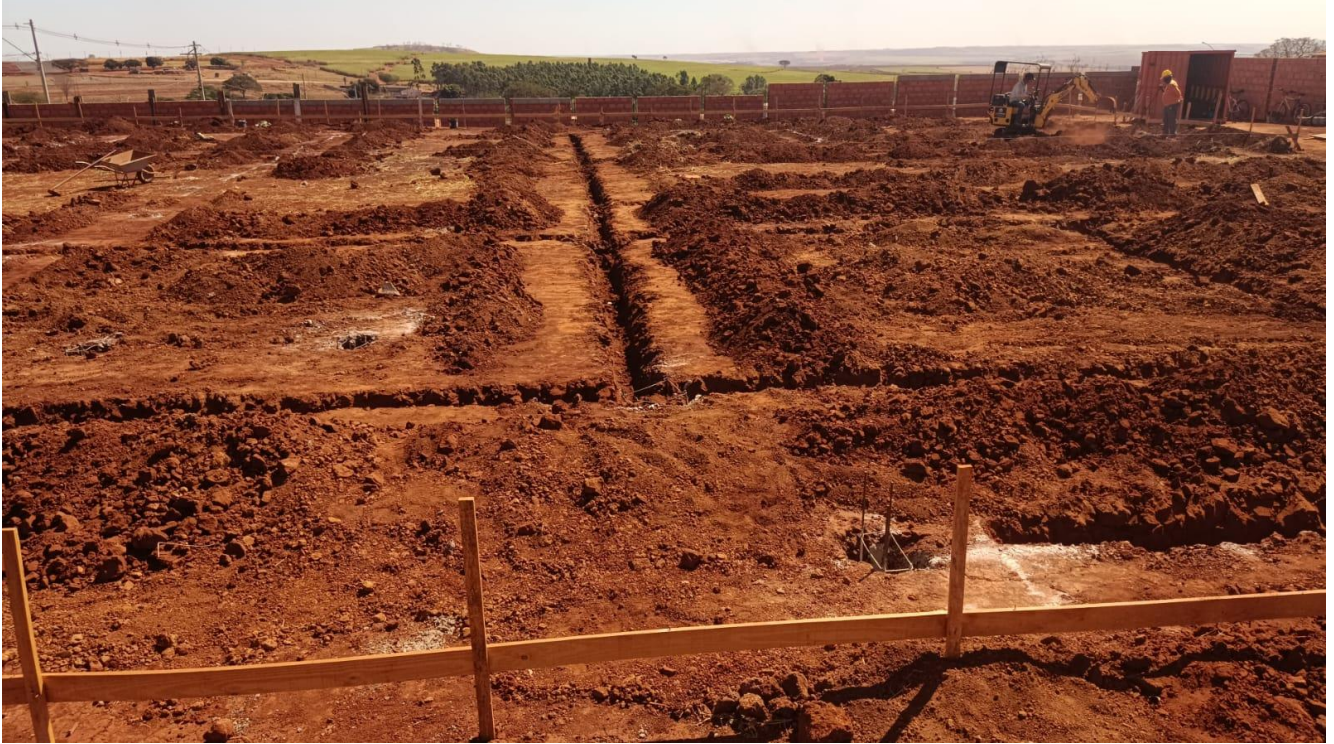
Foto 11 - Referente a escavação mecanizada das vigas baldrames.
