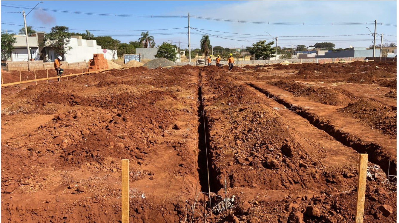
Foto 16 - Referente a escavação mecanizada das vigas baldrames.
