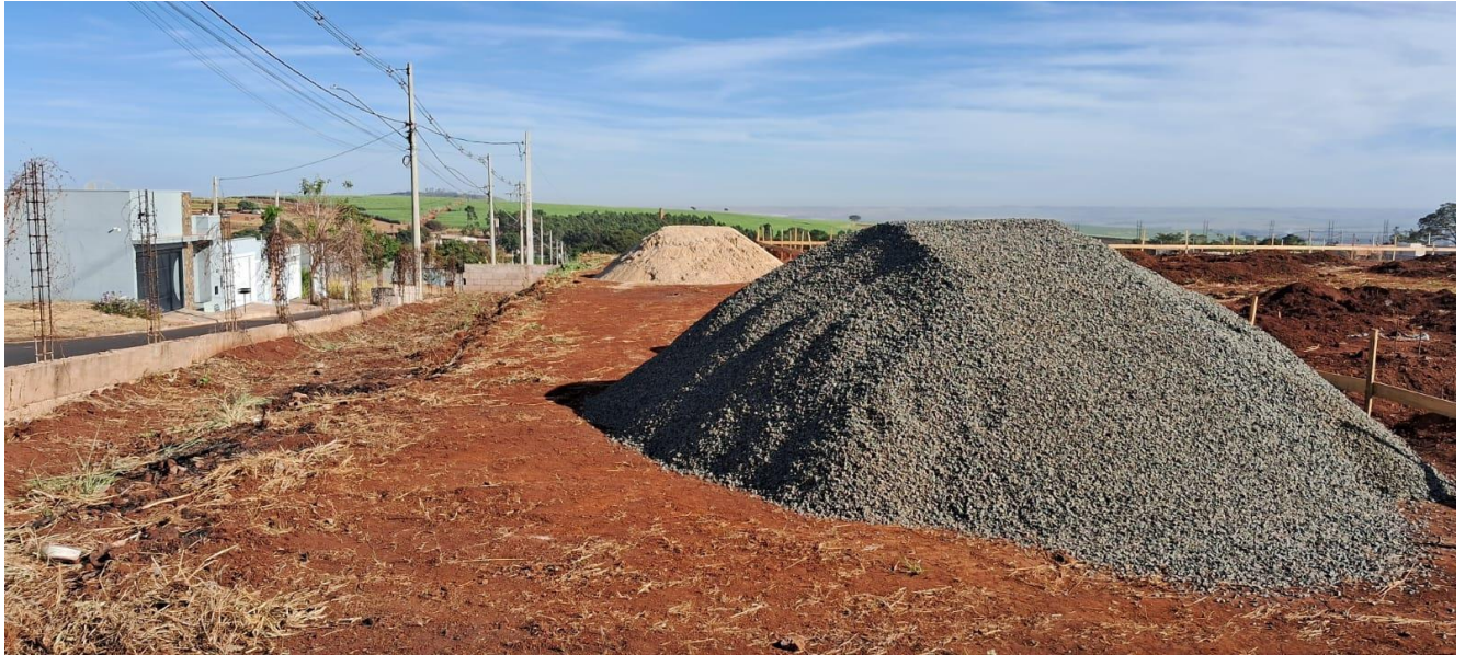
Foto 07 - Referente aos serviços de gabarito da obra para escavação para realização das vigas baldrames.
