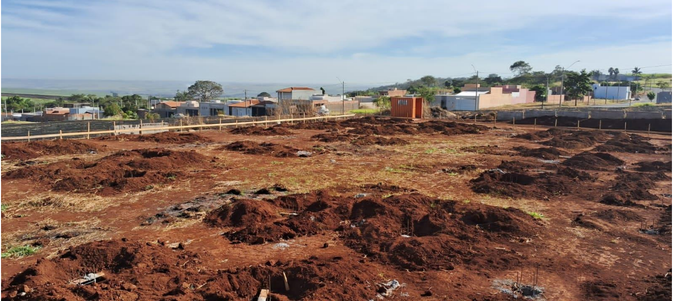
Foto 09 - Referente aos serviços de gabarito da obra para escavação para realização das vigas baldrames.
