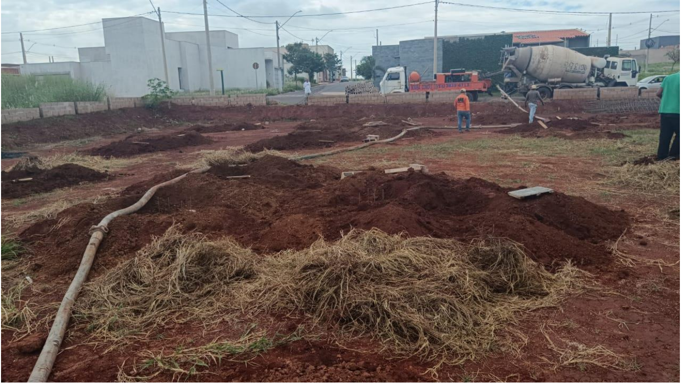
Foto 01 - Referente aos serviços de concretagem das estacas armadas escavadas com profundidades variando entre 7,5 metros e 13 metros de profundidade, com diâmetros variando de 0,30 m a 0,50 m.
