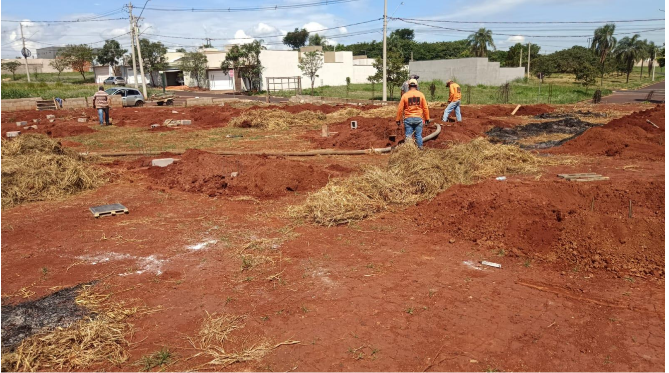
Foto 02 - Referente aos serviços de concretagem das estacas armadas escavadas com profundidades variando entre 7,5 metros e 13 metros de profundidade, com diâmetros variando de 0,30 m a 0,50 m.
