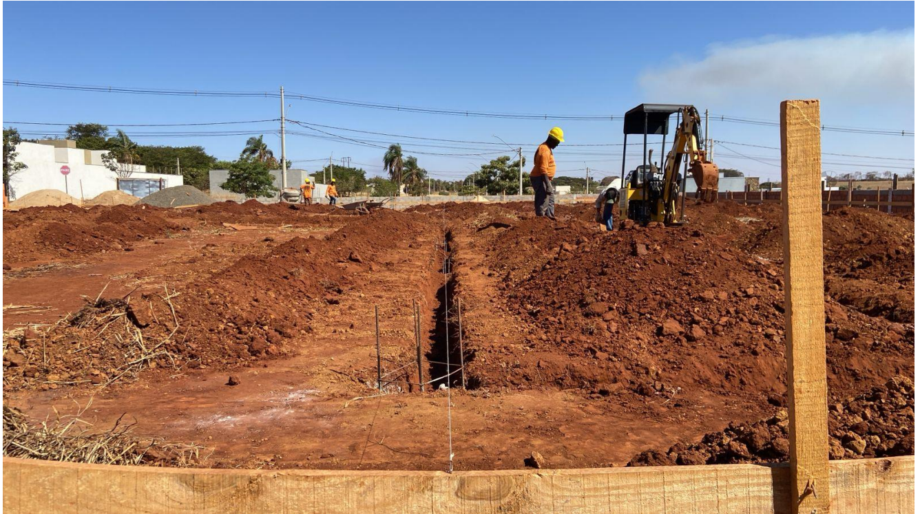
Foto 15 - Referente a escavação mecanizada das vigas baldrames.
