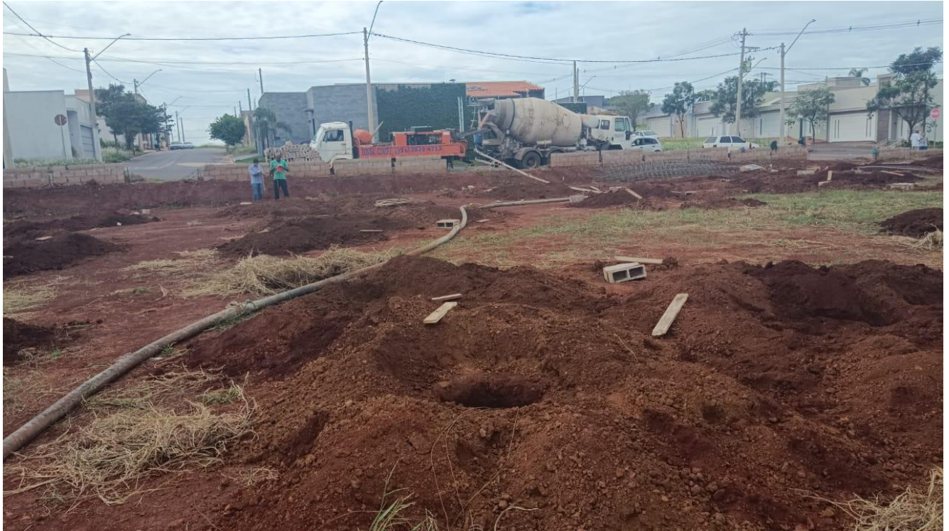
Foto 04 - Referente aos serviços de concretagem das estacas armadas escavadas com profundidades variando entre 7,5 metros e 13 metros de profundidade, com diâmetros variando de 0,30 m a 0,50 m.
