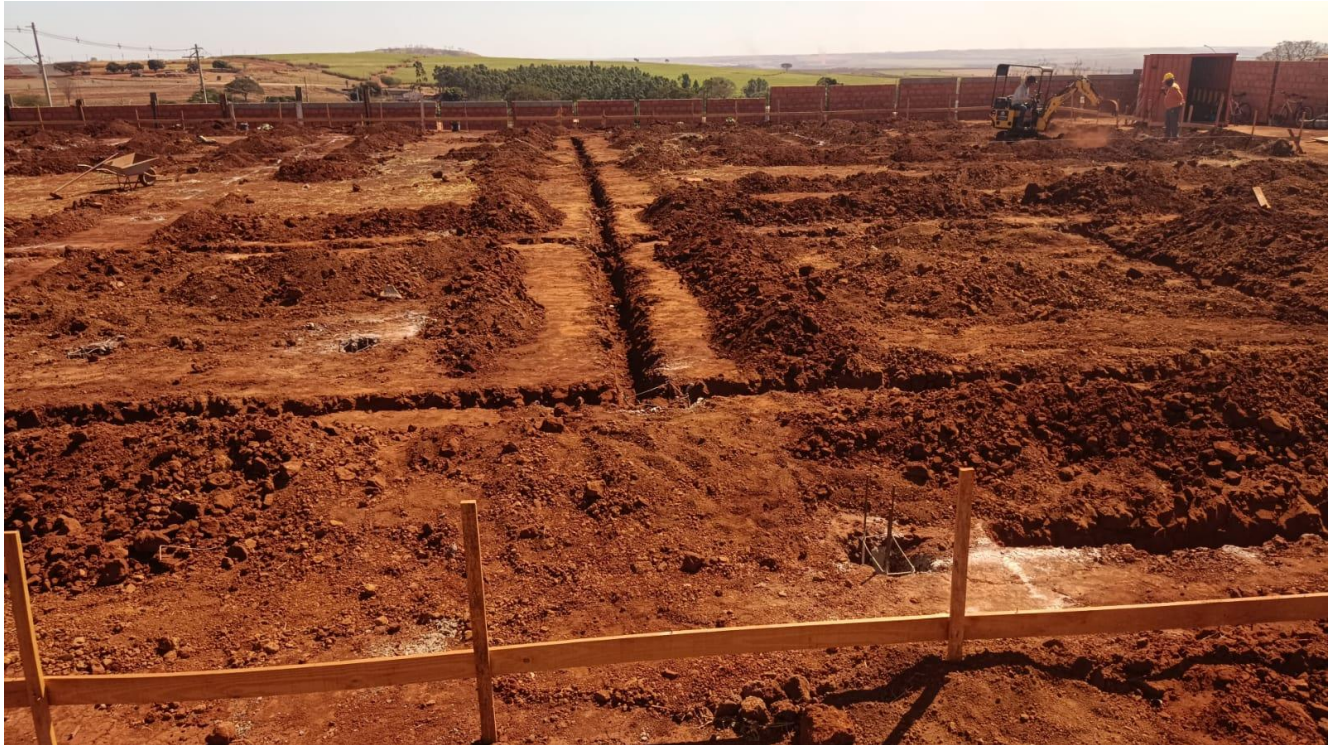
Foto 14 - Referente a escavação mecanizada das vigas baldrames.
