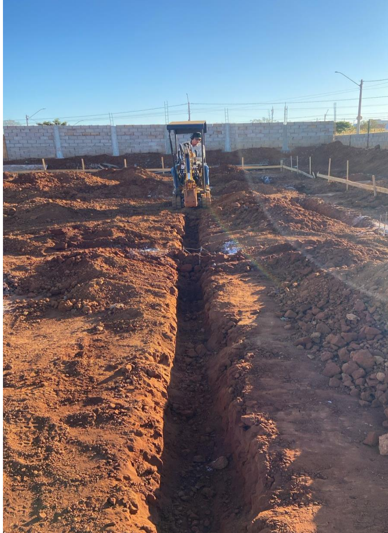
Foto 12 - Referente a escavação mecanizada das vigas baldrame.
