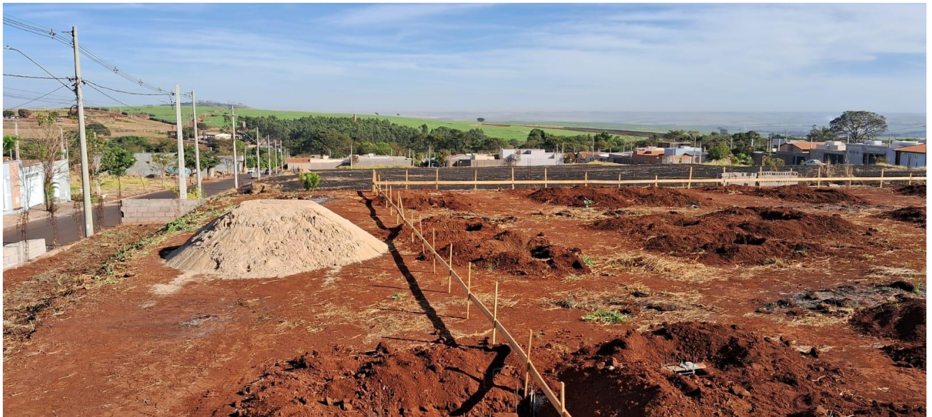
Foto 08 - Referente aos serviços de gabarito da obra para escavação para realização das vigas baldrames.
